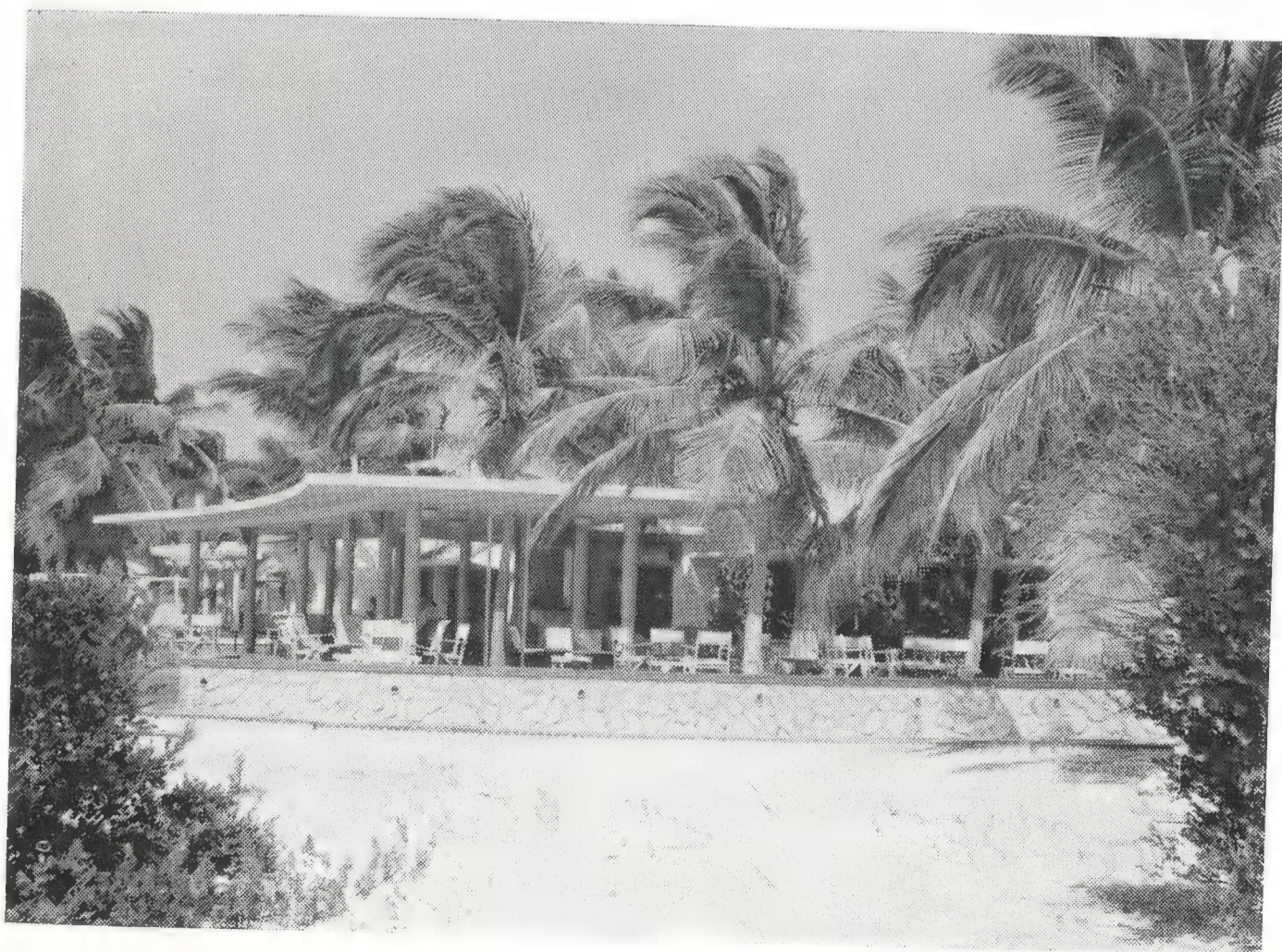
Het Basiruti Hotel, gelegen aan de Palm Beach te Aruba
